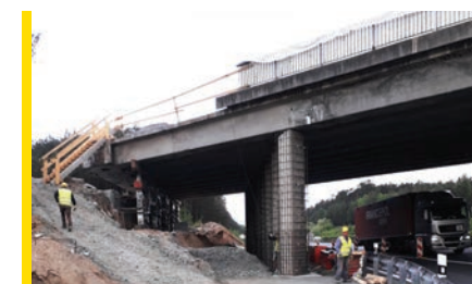
Poříčany - stav během realizace
