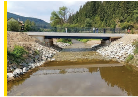
Rekonštrukcia mosta - Čierny Balog
