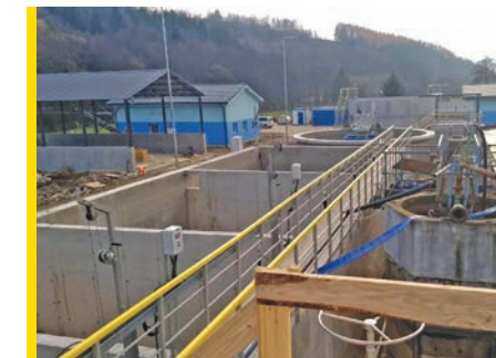
Rekonštrukcia čističky odpadových vôd v meste Hriňová
